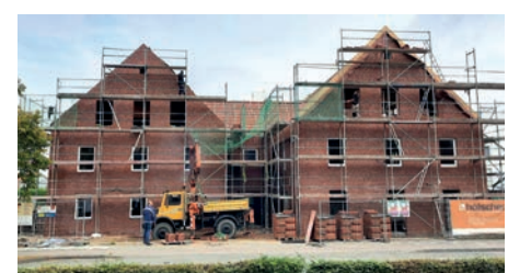
Wohn- und Geschäftshaus Lindenstr. 20, Appelhülsen (z. Zt. im Rohbau)
